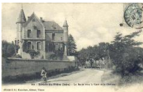
La route vers la Gare et le Château
